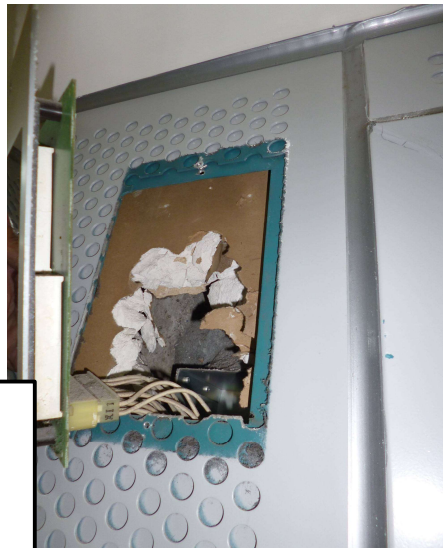
一樓幕板包覆處理。 (安裝顯示器)
